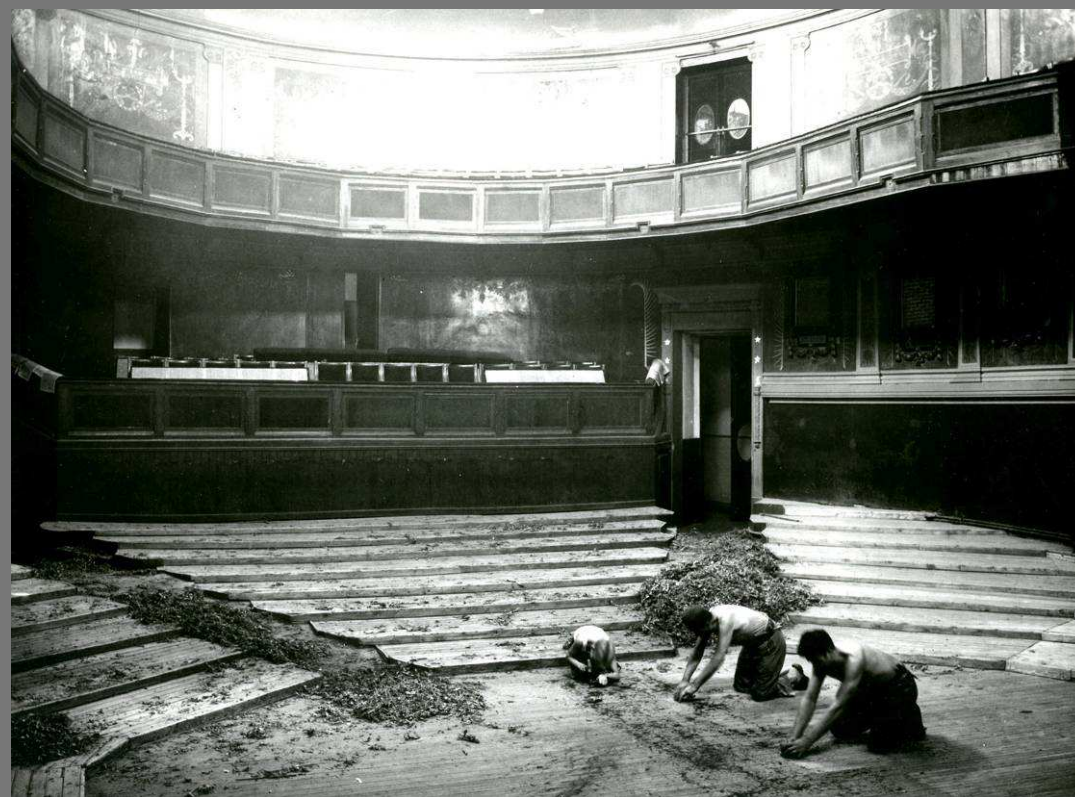
Fotografía nº 5. Trabajos de lijado del suelo del salón de actos. 1952 Archivo del Ateneo de Madrid
