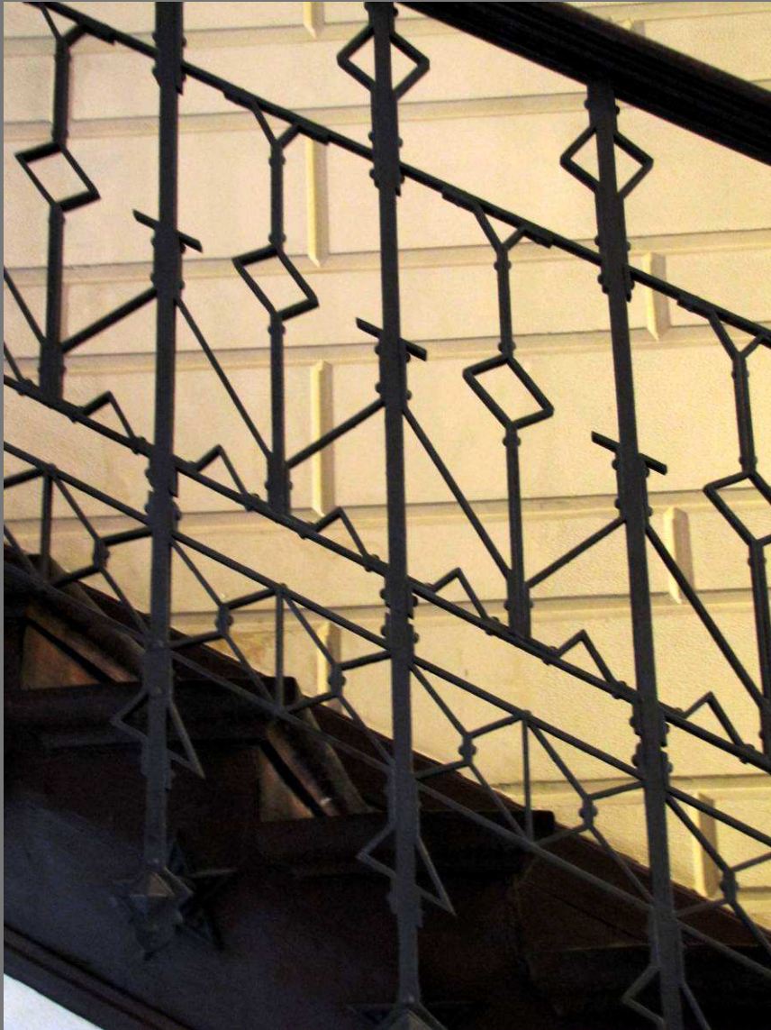
Barandilla de la escalera de la entrada en la actualidad. Foto Olivera
